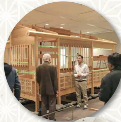
茶室「蓑庵」実物大模型の組立工事見学会
